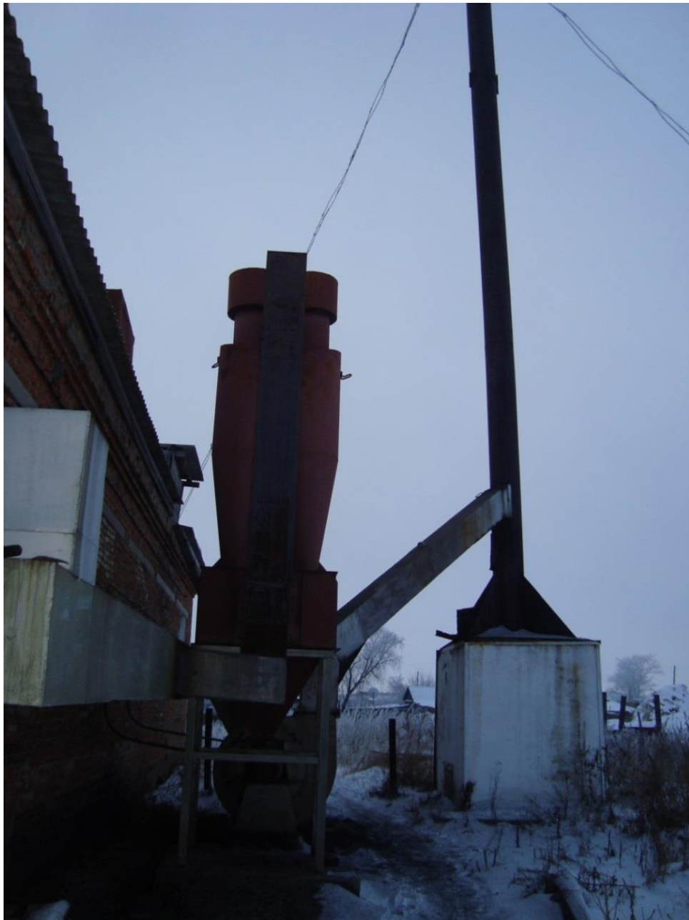
Рисунок 1.5 – Дымовая труба котельной с. Зубовка
